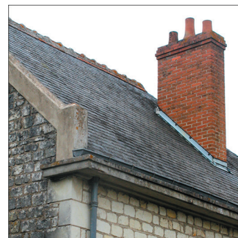
détail corniche, rondelis
