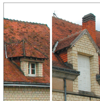
détail lucarne capucine (à gauche), détail lucarne pendante (à droite)
